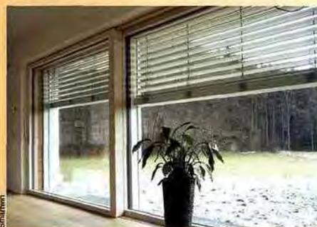
La fenêtre coulissante Smartwin Sliding en bois/alu est un coulissant à levage portant du triple vitrage.
