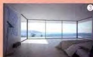
Ici, ( photo n° 1 ) les vantaux libres du Turnable Corner™ vont se glisser dans un galandage à l'intérieur de la maison (photo n°2). Une fois les vantaux cachés et grâce au rail invisible™, du sol au plafond, rien ne permet de deviner qu'une baie vitrée vient fermer cette magnifique terrasse ouverte sur la mer, et lorsque celle-ci est fermée, les montants de 22 mm ne viennent pas gâcher cette magnifique vue. (photo n°3)
