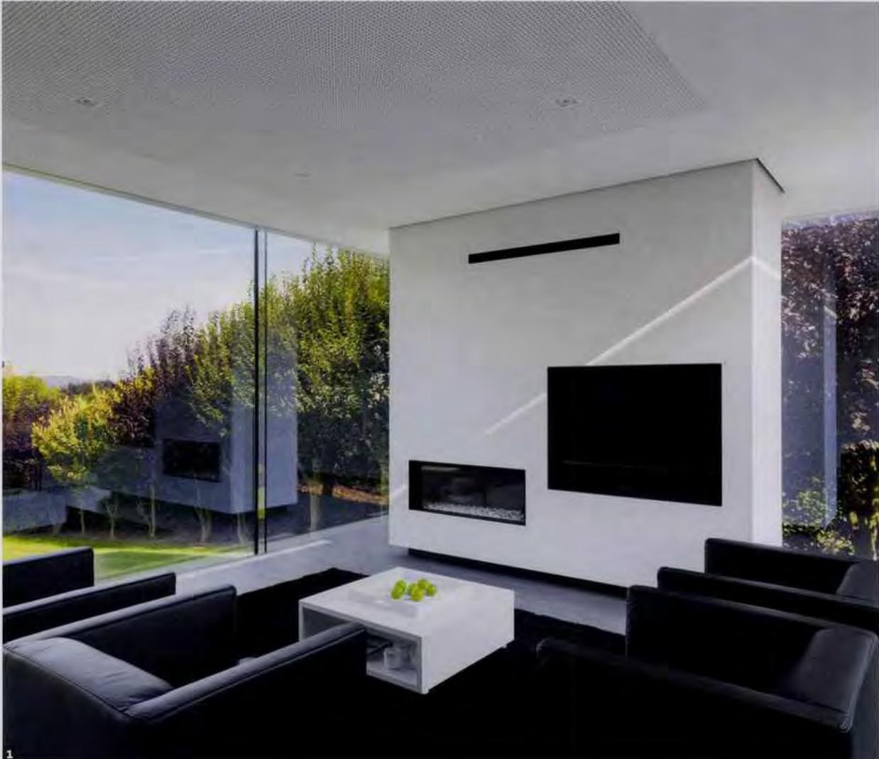
**1. HiFinity** Coulissant aluminium minimaliste, disponible en version motorisée ou manuelle deux rails, et avec solution d'angle trois rails (Reynaers). Châssis entièrement intégrés dans les murs pour des masses vues\* réduites au minimum (masse vue chicane centrale: 35 mm). Dimensions maximum ouvrant: 350 cm. Épaisseur de vitrage possible jusqu'à 36 ou 38 mm. Prix selon devis. [www.reynaers.fr](http://www.reynaers.fr)
