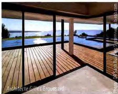
\* Coulissant 2 vantaux, L 2,35 x h 2,18 m, double vitrage 4/16/4,  $U_g = 1$  Warm Edge TGI, NF EN ISO 10077, 1/2).
