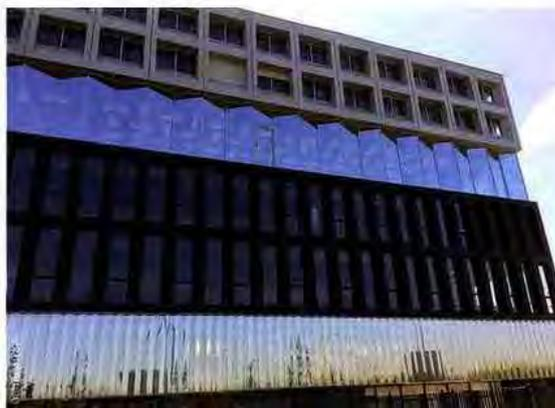
Mur-rideau à capot serreur S60G et menuiseries 66BT Paralu - Pose des murs-rideaux en accordéon avec vitrage réfléchissant - Campus EDF à Saclay (91) - Architecte : Calq
