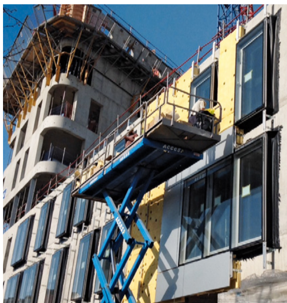
La pose des shadow-box, en toute précision.
