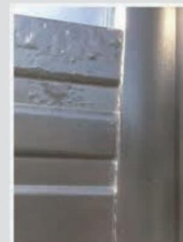
Exemple de corrosion d'un portail laqué aluminium, situé à 8 km de la mer, sans traitement Sea Side Ox
