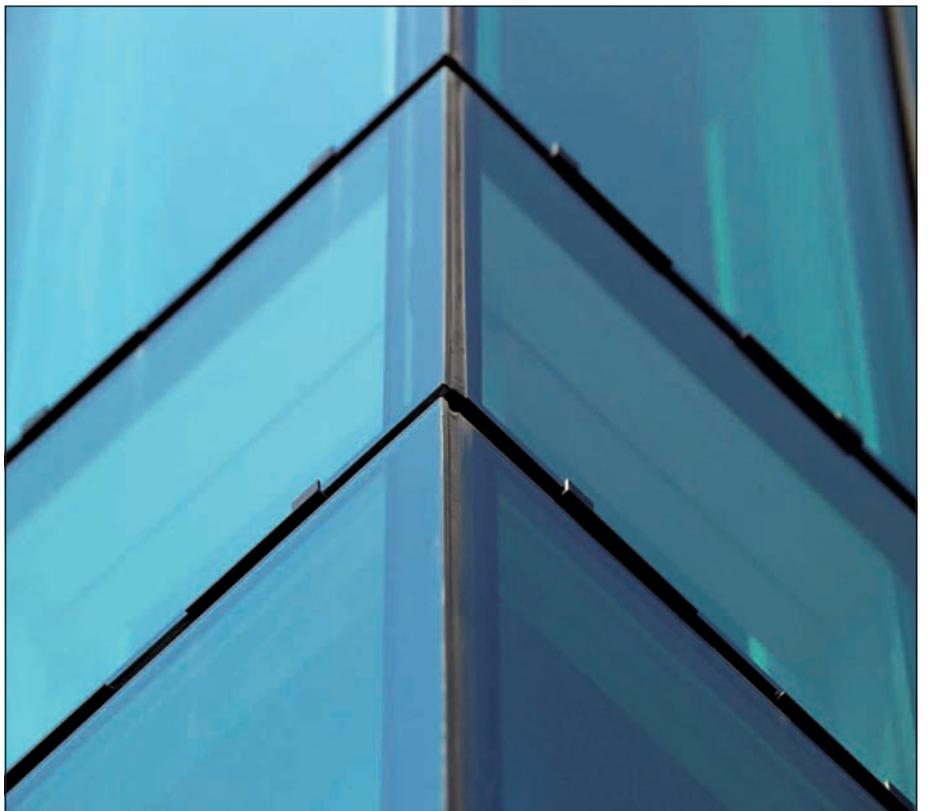
Elegance 52 SG est un système de profilés en aluminium pour mur-rideau avec Vitrage Extérieur Collé (VEC). Elegance 52 SG est une solution ne présentant aucune différence visuelle entre les panneaux fixes et les ouvrants. Système intégré de fenêtre ouvrant caché vers l'extérieur.
