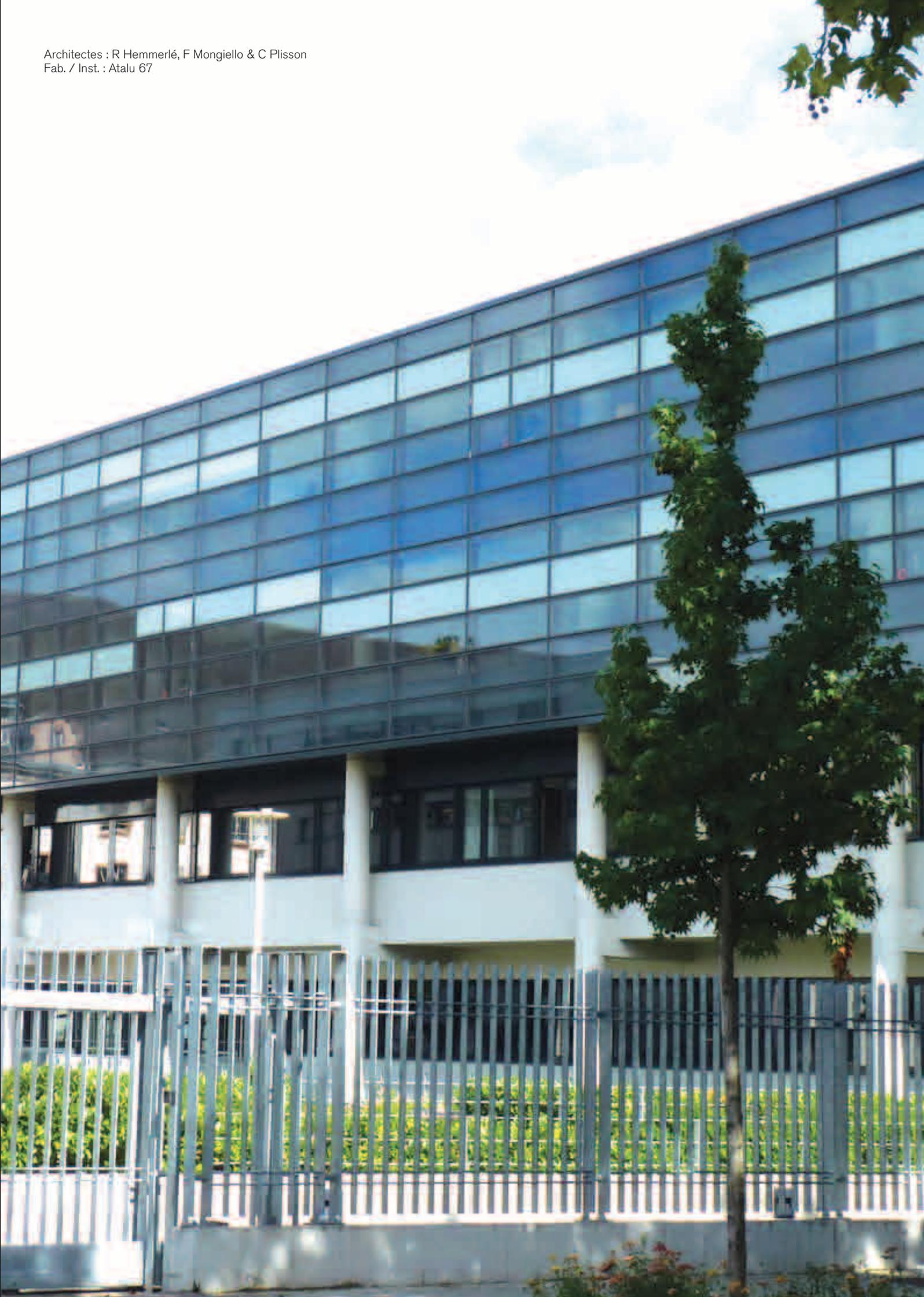
Véritable innovation sur le plan technique, Elegance 72 est un système de mur-rideau avec modules fabriqués industriellement, dans des conditions de contrôle parfait. Une intervention rapide sur le chantier est suffisante.
